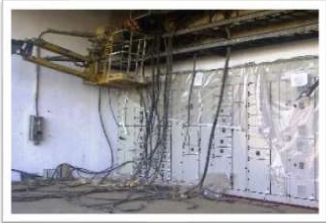
Instalación nuevos controles areas
