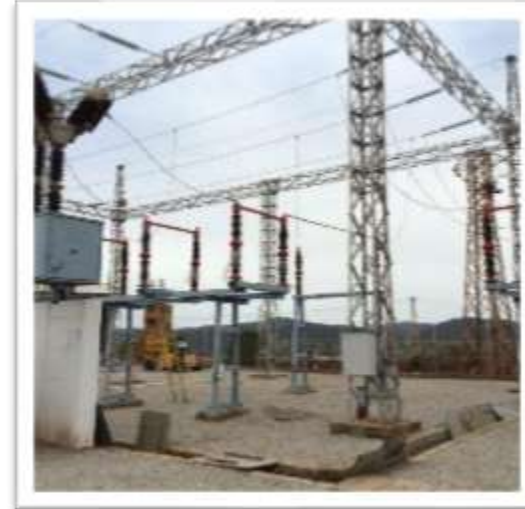
Reforma subestación principal
