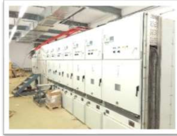
Reforma subestación principal
